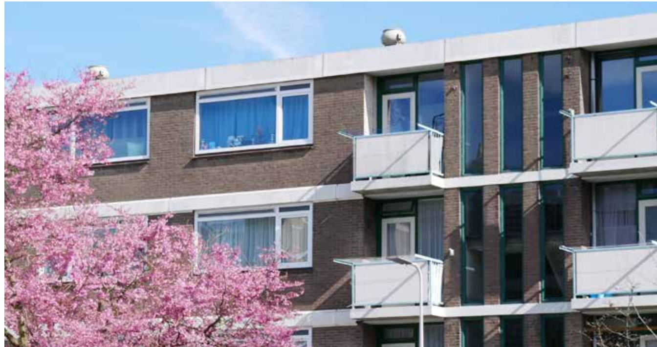
Een moderne gebouwwitstraling, een verhoogd wooncomfort en een minimaal energieverbruik staan centraal.
