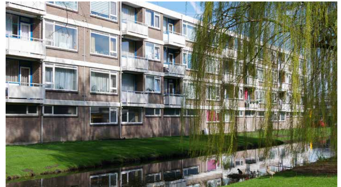
Verweij Houttechniek voorziet alle woningen van nieuwe balkondeuren, voor- en achterdeuren, borstweringspanelen en klepramen. Bovendien levert zij de portiekkozijnen voor de 72 portieken.
