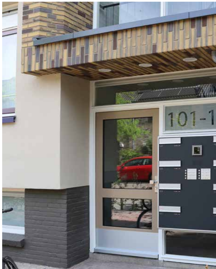
Elk projectblok wordt afgesloten met de vervanging van de portiekentredeuren.
