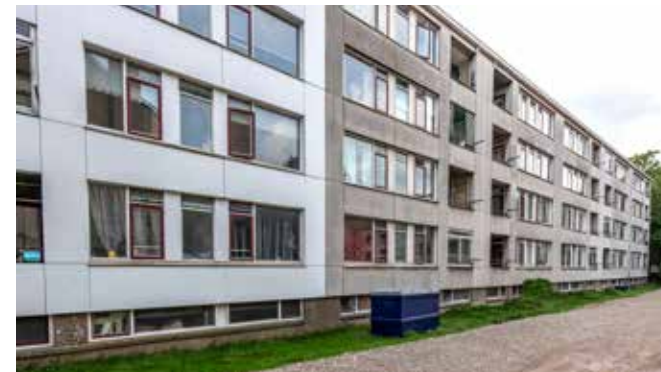
Tijdens de verbetering en verduurzaming wordt de complete gebouwschil aangepakt.
