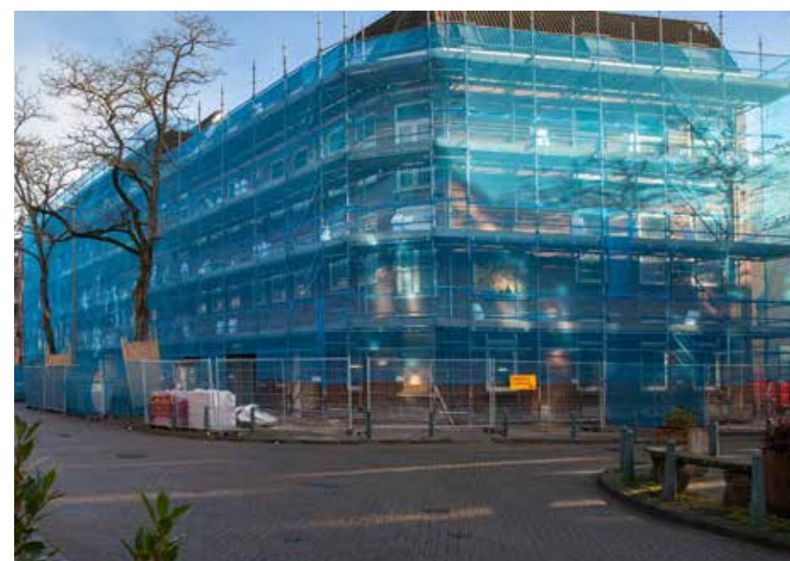
De portieketagewoningen aan de Soetendaalseweg staan nog in de steigers.
