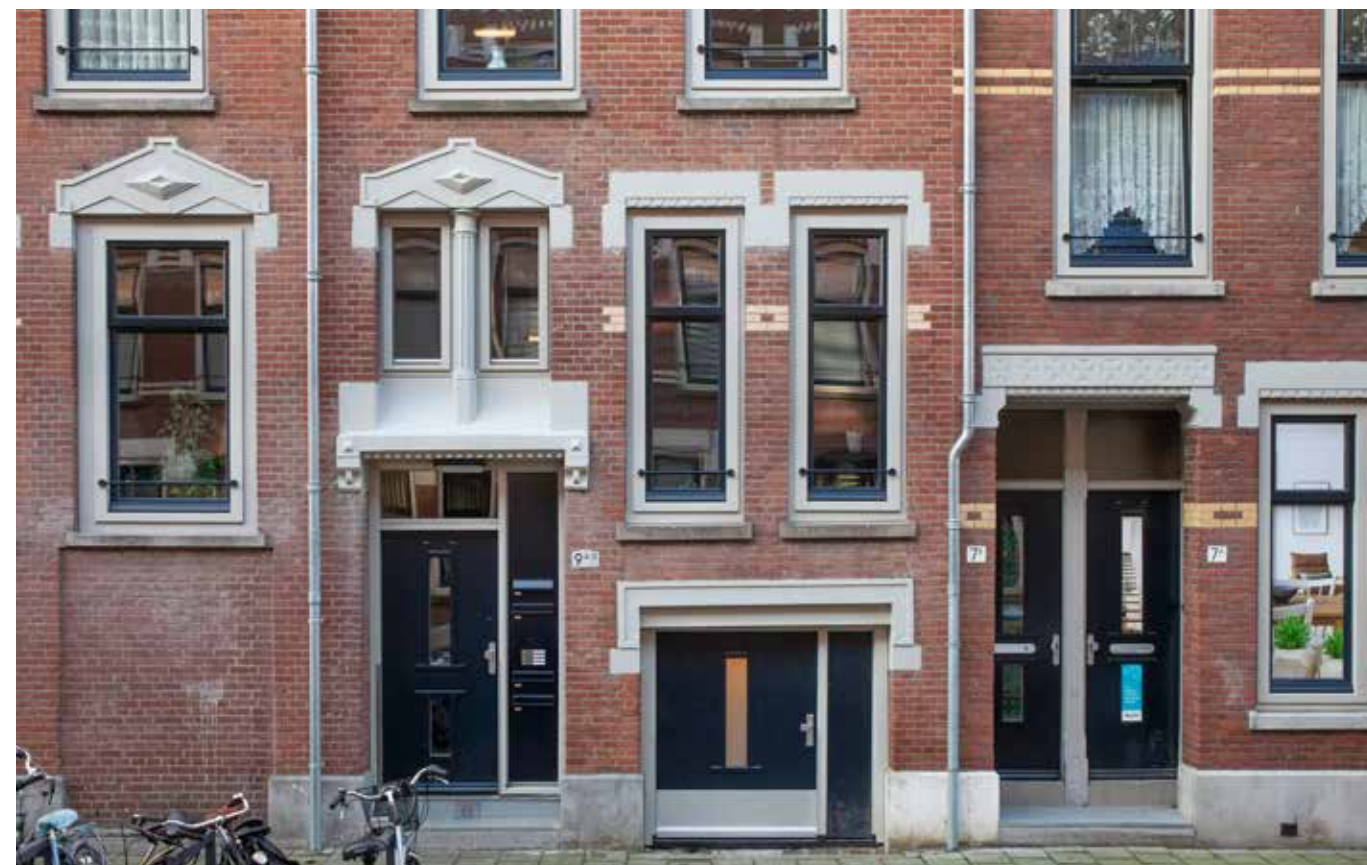
De fraai gerenoveerde gevels van de portieketagewoningen aan de Hoeksestraat.
