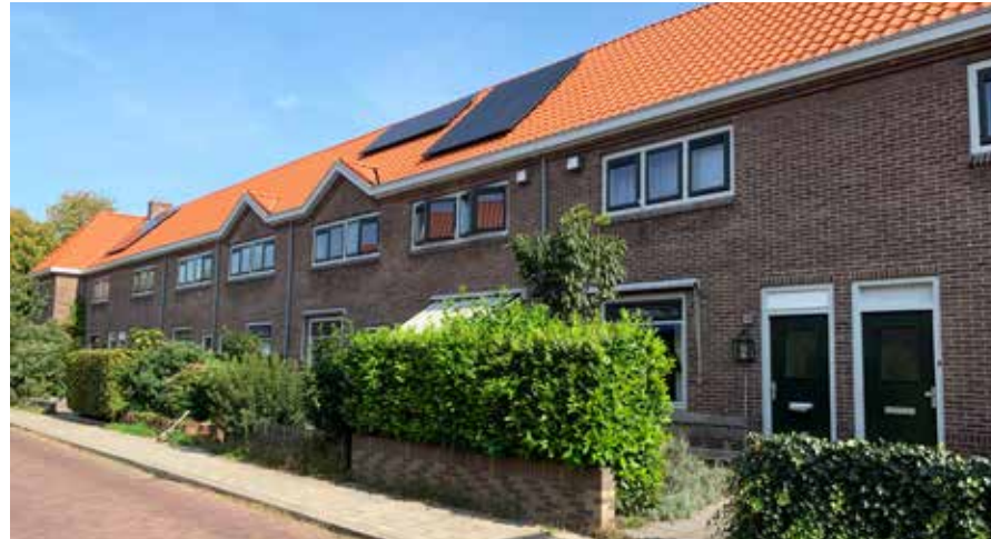
Om de uitstraling van de wijk in ere te herstellen, maken de eerdere aanpassingen plaats voor ramen en deuren die de uitstraling van weleer evenaren, maar dan wel met de isolatiewaarden en tochtwering van nu.
