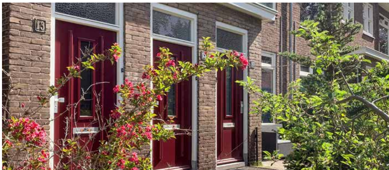
De ramen en deuren bevatten een veelvoud aan detailleringen, die als basis dienden voor de vervangingsproducten.
