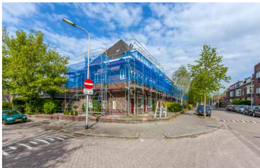
In verschillende fases zijn 180 woningen (2017), 164 woningen (2018) en 157 woningen (2019) aangepakt.
