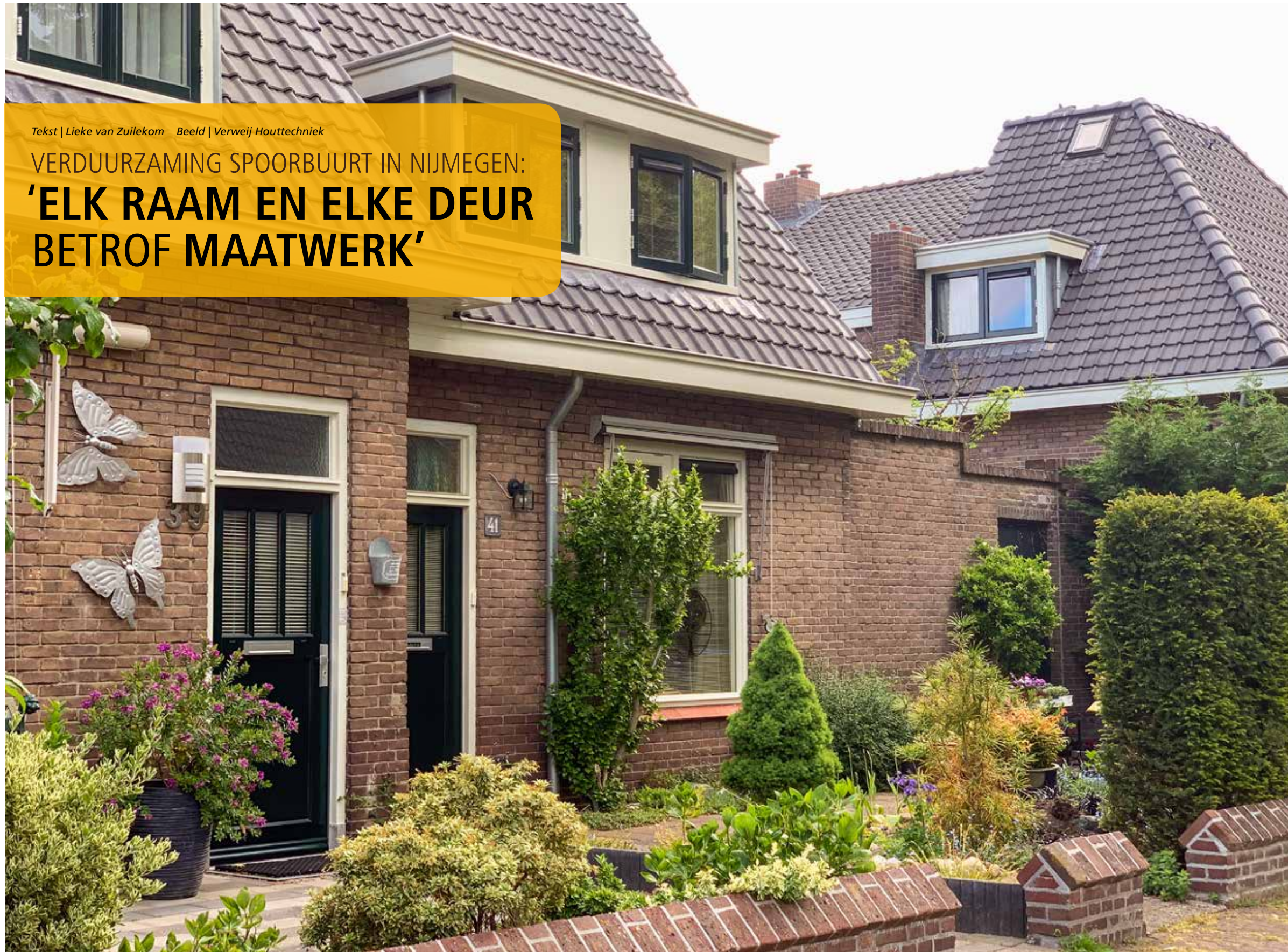
Tijdens de verduurzaming van de 501 karakteristieke, vooroorlogse woningen in de Spoorbuurt in Nijmegen heeft Verweij Houttechniek alle draaiende delen ingemeten, geproduceerd en vervangen.
