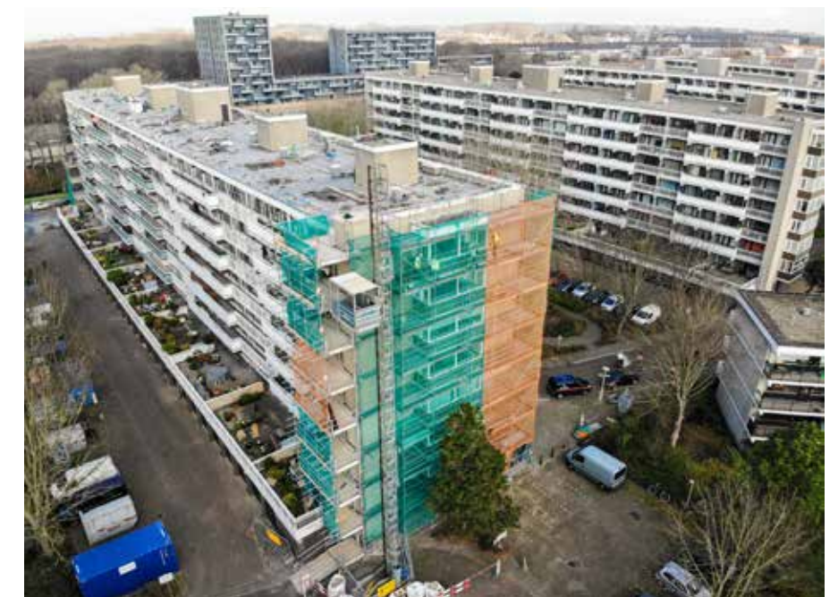
De twee woontorens ondergaan groot onderhoud en energetische verbeteringen.
