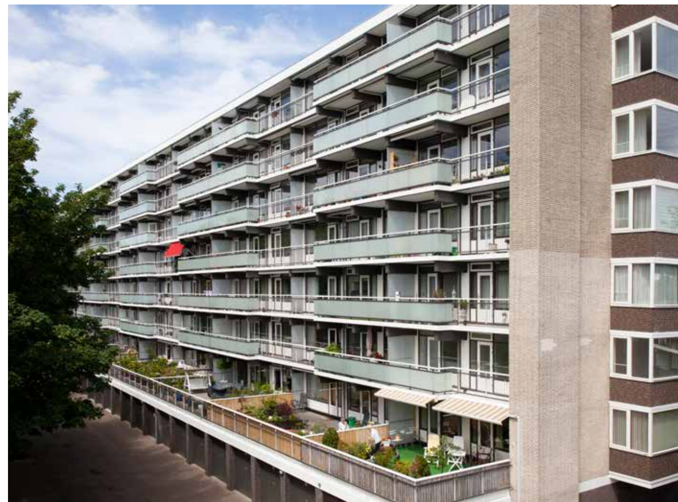
In de appartementen in de woonwijk Waldeck worden de gedateerde ramen en deuren vervangen door kant-en-klare Columbus ramen en deuren van Verweij.
