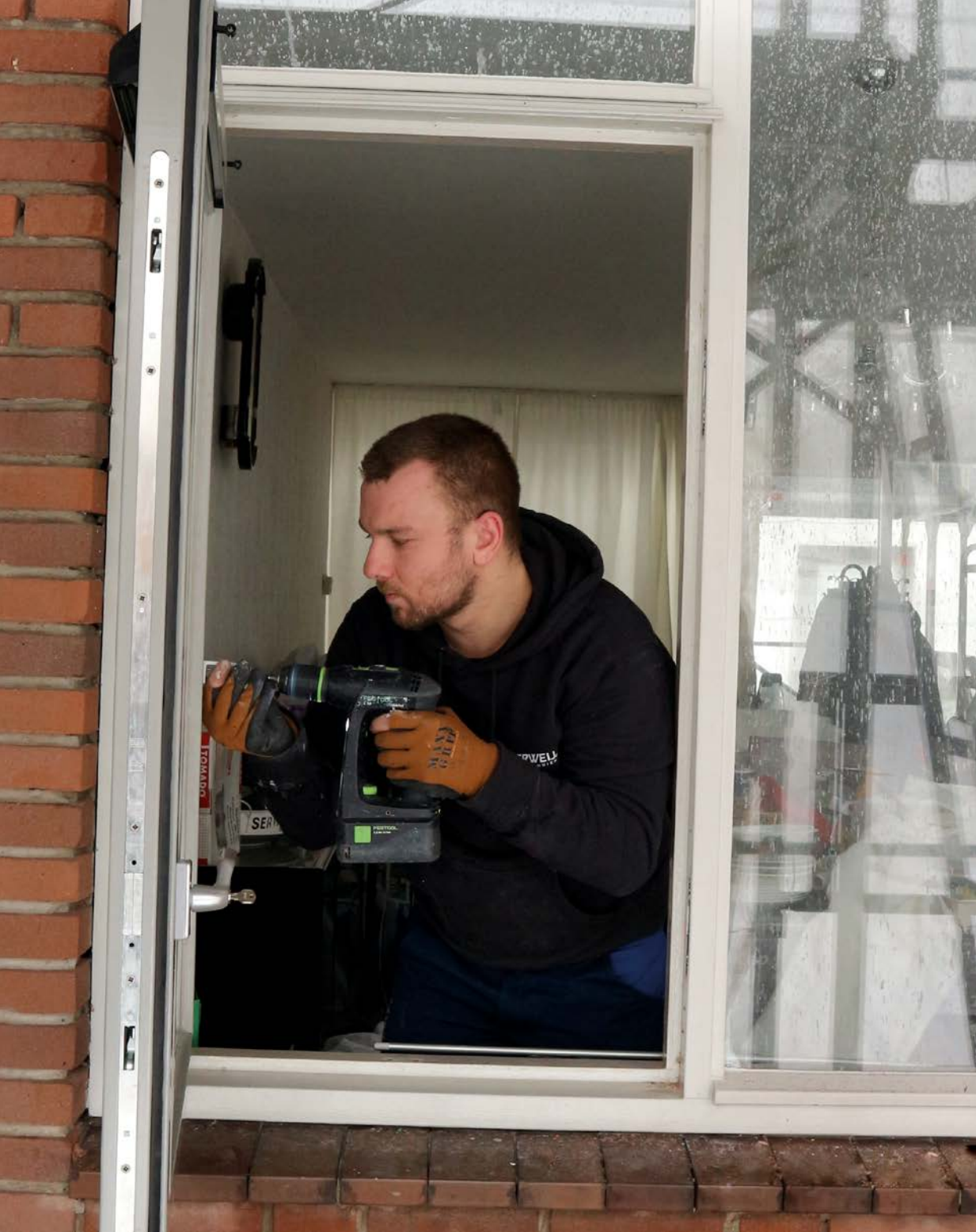
Medewerker Roy van Dam monteert een raam in Eckart. DIONNE VERSTEGEN
