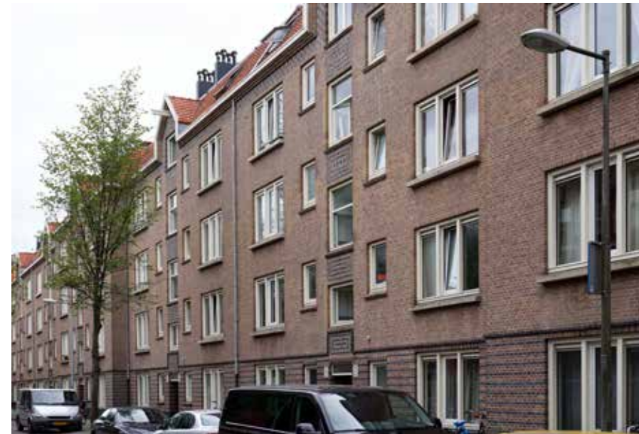
De originele houten kozijnen in de voorgevel werden in de vorige renovatiefase uitgerust met kunststofkozijnen met ventilatieroosters bovenop het glas. Die zijn nu door Verweij Houttechniek vervangen.
