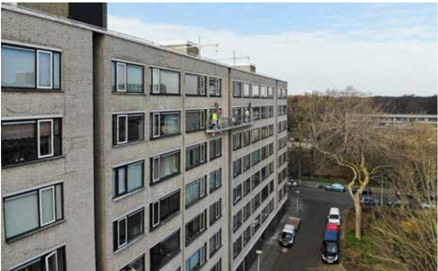
De bestaande ramen worden vervangen door nieuwe kant-en-klare exemplaren, uitgerust met hoogrendementsglas. Ook de voordeuren worden vernieuwd.
