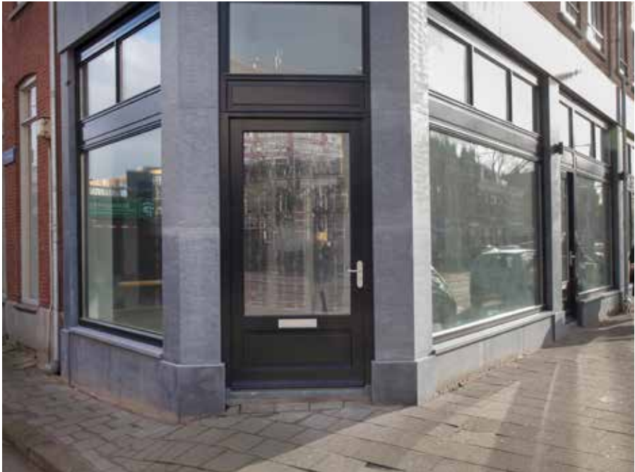
Hoogwaardig gerenoveerde winkelpuizen aan de Benthuiserstraat.
