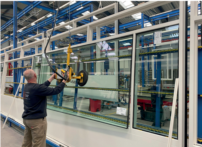
Glaszetten in de kozijnen.
